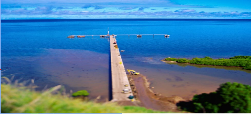
Qarani Jetty, Gau
